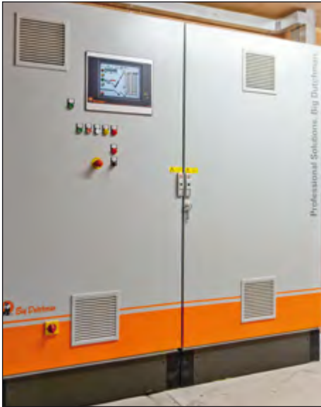
集成了 »OptiSec 粪便干燥通道 «amacs 模块的控制柜
