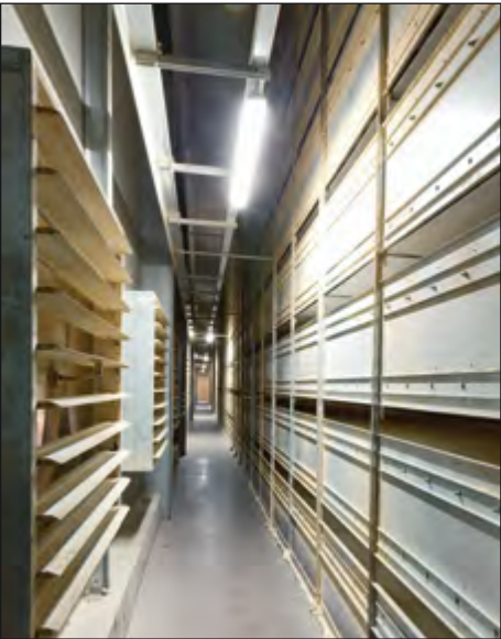
约为 25 帕正压的压力通道
